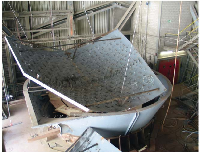
10 Installation of Cyclone C4 Montage des Zyklons C4
