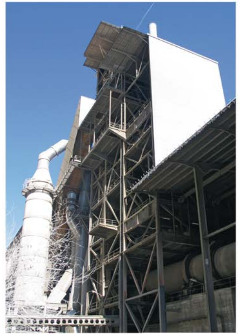
2 Preheater tower and former filter tower Wärmetauscherturm und ehemaliger Filterturm
