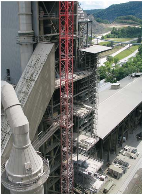
6 Stepped installation platforms Treppenförmig abgestufte Montagebühnen
