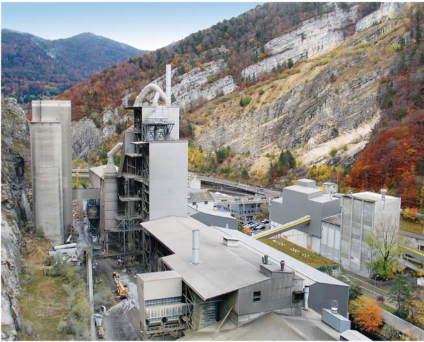
1 Overall view of the Reuchenette cement plant after completion of Project 880 RO3 Gesamtansicht des Zementwerkes Reuchenette nach dem Projekt 880 RO3
