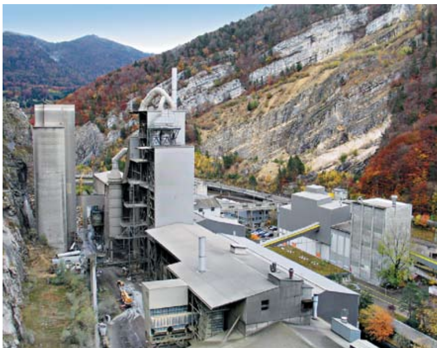
1 Общий вид цементного завода Reuchenette после завершения проекта 880 R03
