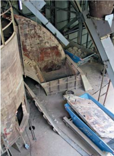
9 Демонтаж вентиляционного стояка GL32
