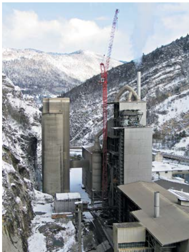
5 Поворотный кран с подвижной стрелой, типа WK 160В и рабочий шатёр
