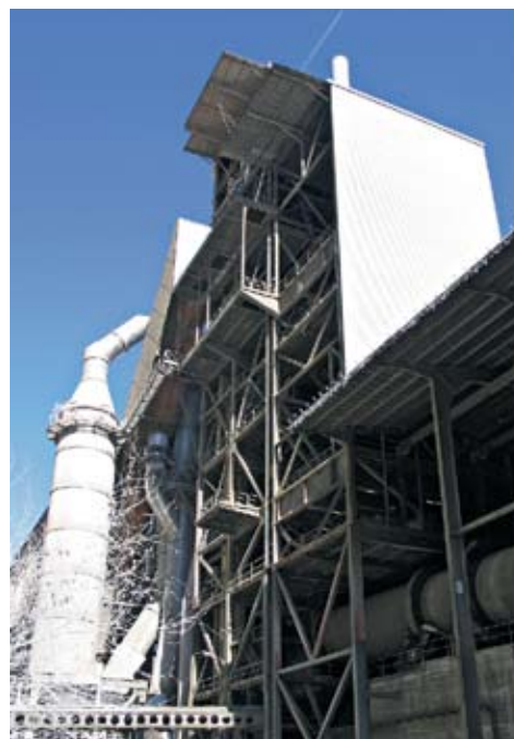
2 Башня теплообменника и здание бывшего фильтровального участка
