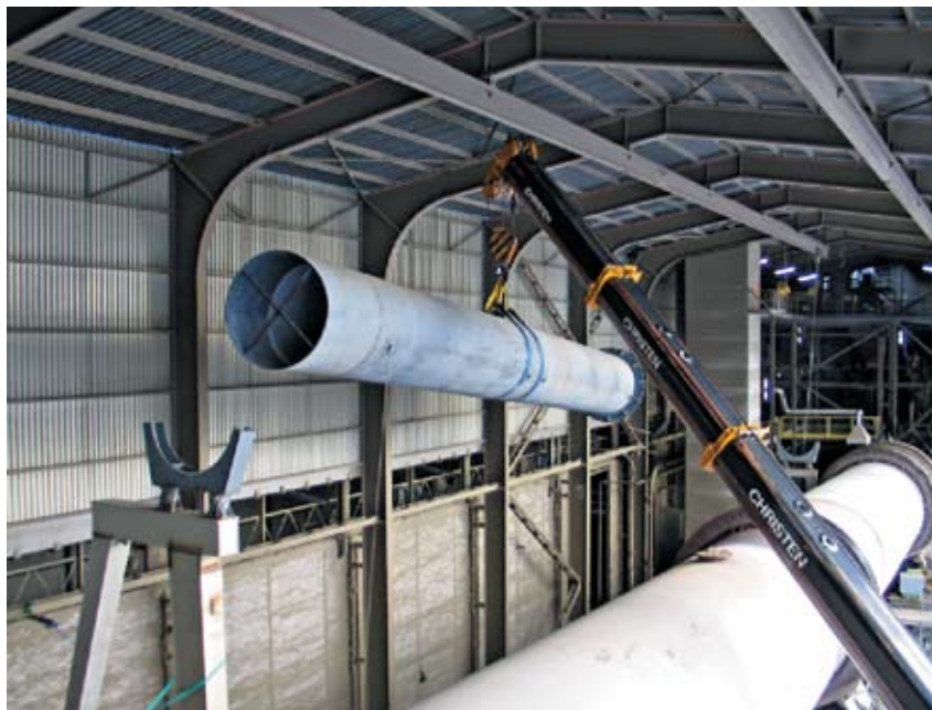
7 Монтаж воздуховода третичного воздуха на этапе 2
