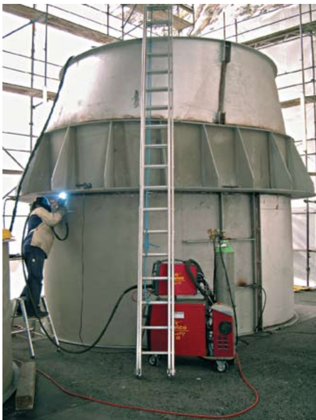
4 Предварительная сборка компонентов оборудования
